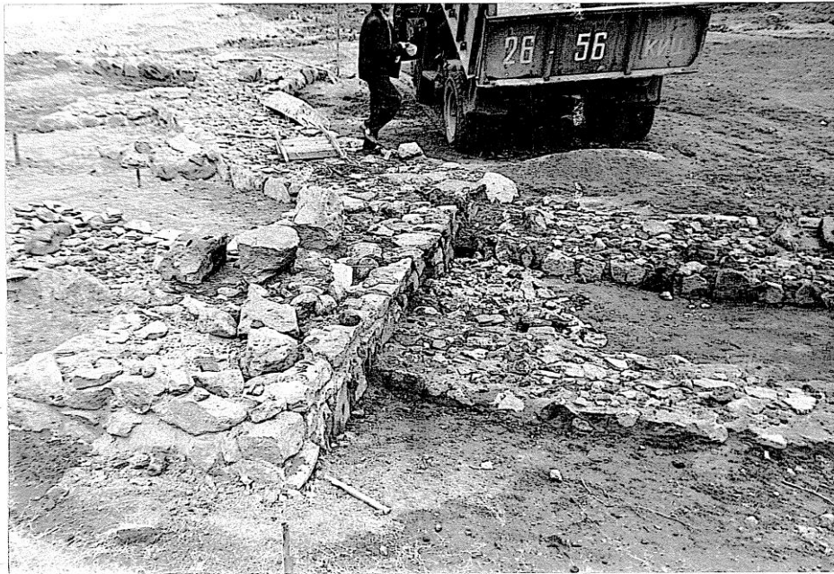
Рис. 1. Фундаменти центричної споруди Х ст.. на Старокиївській горі.
